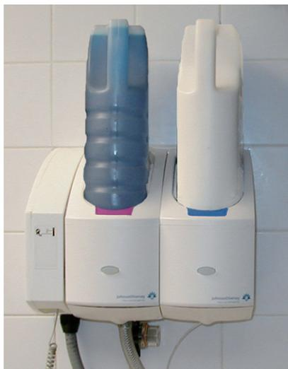
Suma RevoFlow è l'innovativa apparecchiatura di dosaggio per prodotti RevoFlow liquidi e in polvere per il lavaggio meccanico delle stoviglie.
